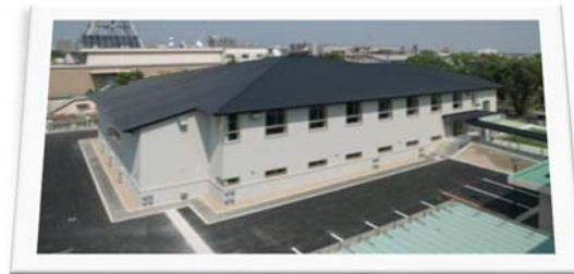
附属小学校体育館(平成26年度9月完了 新営)
