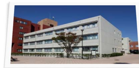
講義・基礎実習棟(平成26年9月完了 改修)
